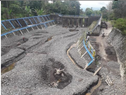
Foto Dokumentasi Kondisi Bendungan Baru
